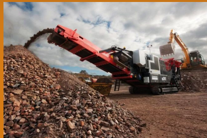
Дробление строительных материалов
